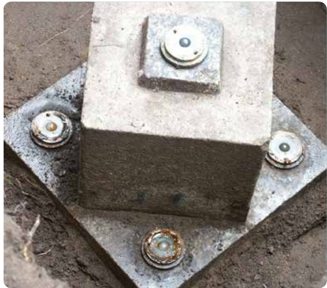
Unterirdische Vermarkung des Normalhöhenpunkts 1912 | © Pemba.mpimaji ( https://commons.wikimedia.org/wiki/File:Hoppegarten2.JPG ), Seitenverhältnis von LGB, https://creativecommons.org/licenses/by-sa/4.0/legalcode
