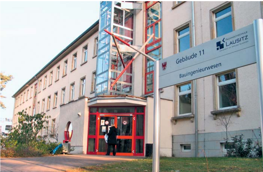
Bild 2: Gebäude 11 mit „Vermessungstechniklabor“
