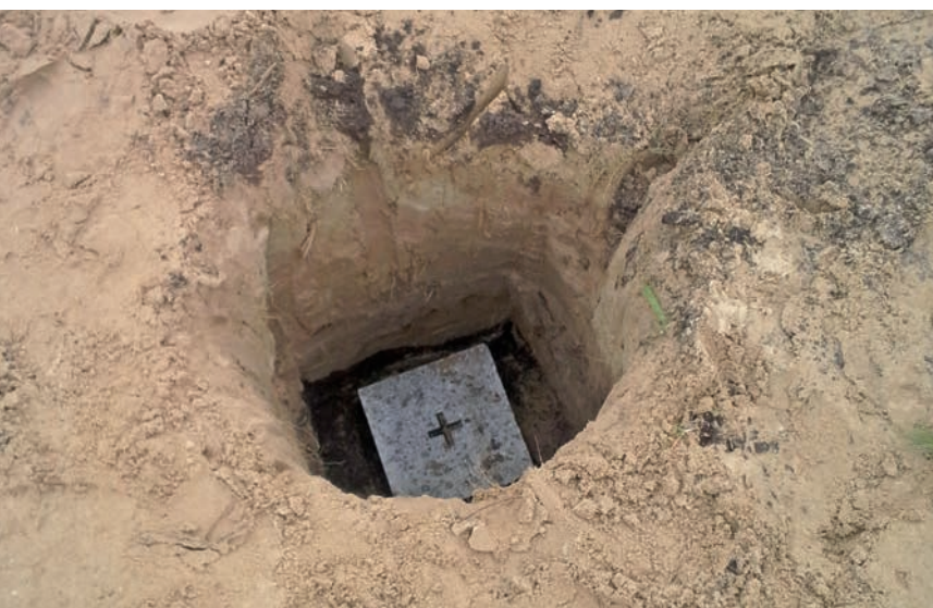
Abb. 2: Neue unterirdische Sicherung eines Grenzsteines
