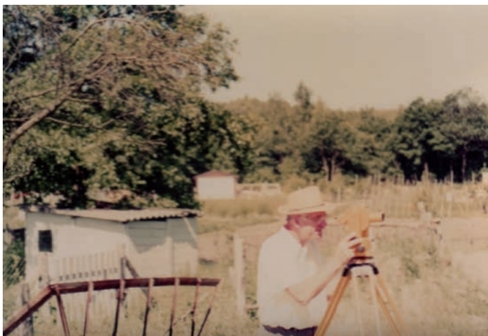
Abb. 2: „Messtruppführer“ bei der Dahlta-Aufnahme (hier neuer Dahlta 010 A) im Sommer
