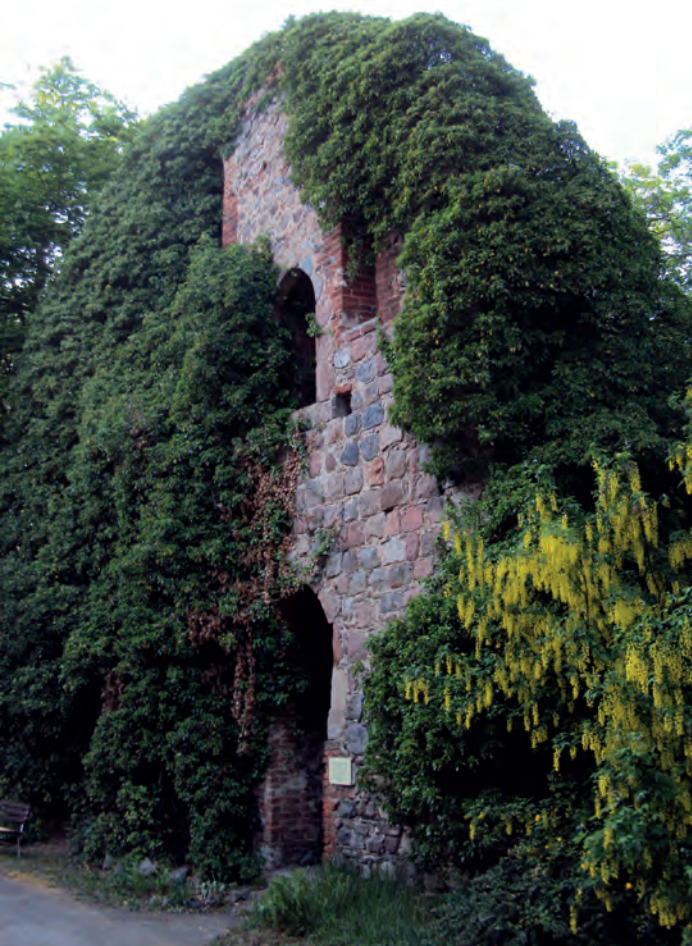
Abb. 3: Giebel des Konventgebäudes vor der Restaurierung [3]
