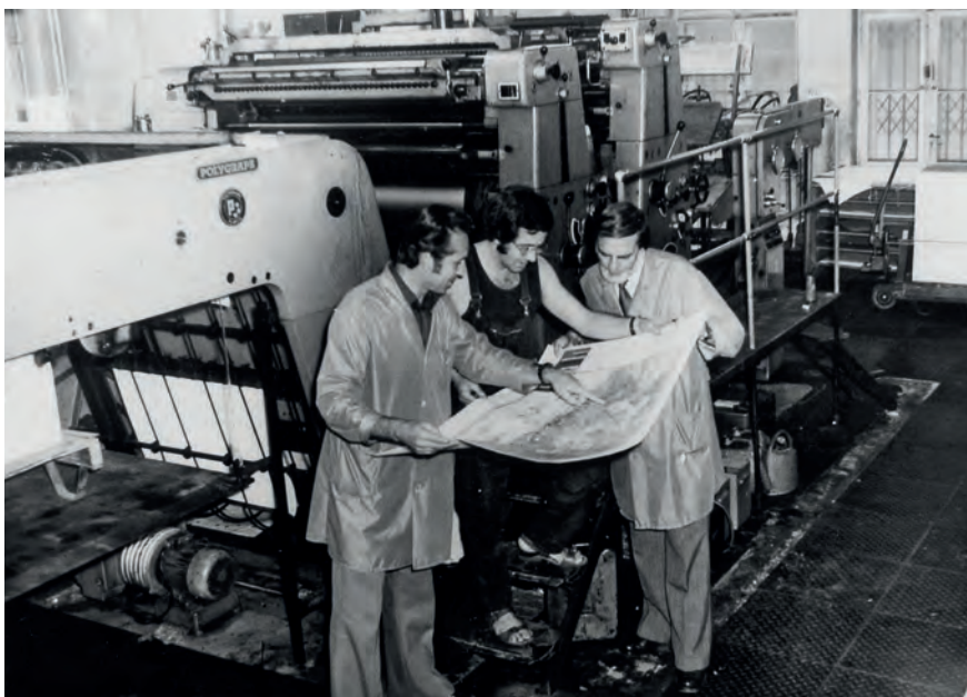
Abb. 1: Zweifarbige Bogenoffset- druckmaschine des Kartographischen Dienstes der DDR in Potsdam, Bildaufnahme 1977
