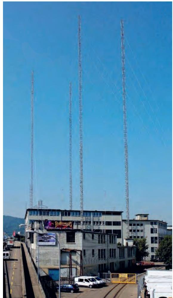
Abb.: das 126 Meter hohe Baugespann des Prime Tower im Juli 2006 (© Ralph Bensberg)
