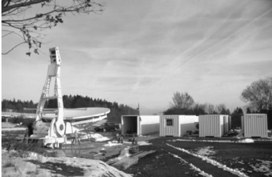
Abb. 3 Das TIGO - Radioteleskop in der Aufbauphase mit 4 Transport-/Betriebscontainern im Hintergrund
