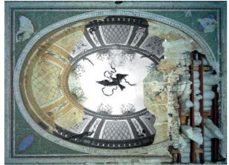
b) Überlagerung eines entzerrten Messbildes nach der Sicherung der Decke (1998) mit einem historischen Messbild (um 1912)
