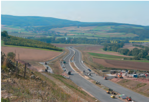
Autobahnabschnitt im Bau
