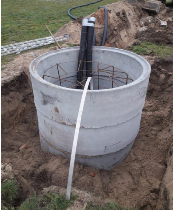
Abb. 2: Bau des Fundamentes und Verlegen des Tiefenernders für den Blitzschutz
