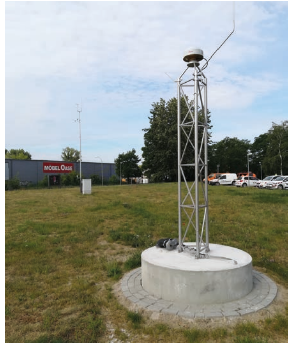
Abb. 3: GNSS-Antenne und Technikschränk
