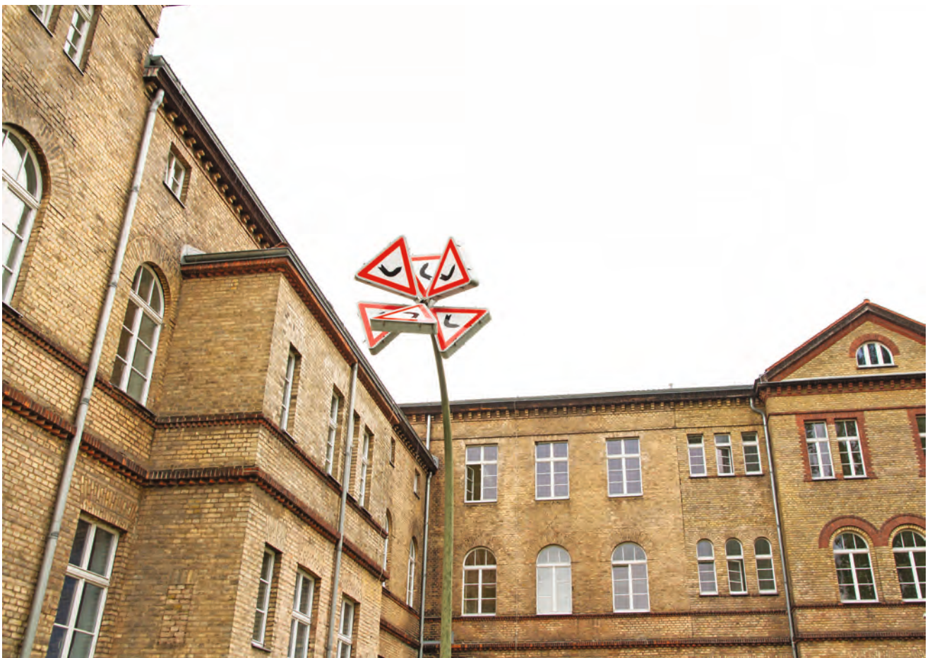
Abb. 2: Bürogebäude der LGB in der Heinrich-Mann-Allee 103 (© LGB)
