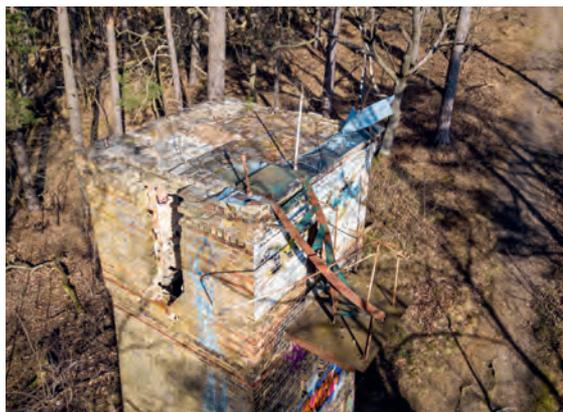
Abb. 10: Mirenhaus auf dem Kleinen Ravensberg, Ansicht der Süd- und Westfassade des Obergeschosses sowie der Dachfläche. Ersichtlich sind die Schäden durch die fehlende Dachabdeckung, die ausgebrochene Fensteröffnung und die freiliegenden Doppel-T-Träger der Kappendecke, Foto: Alina Pilz, 2023
