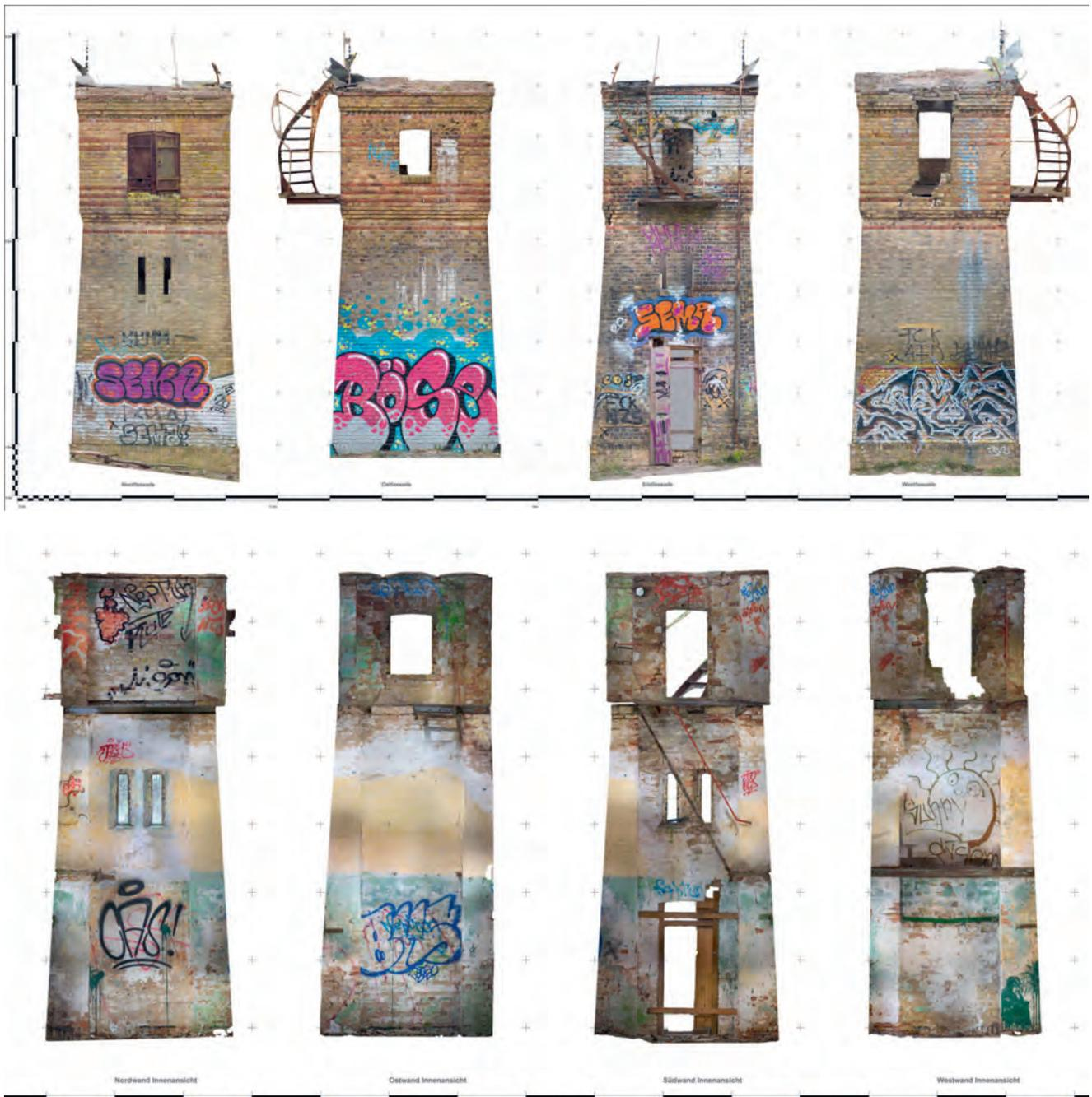
Abb. 3: Mirenhaus auf dem Kleinen Ravensberg, Orthophotos der Fassaden (oben) und der Innenwände (unten), Maßstab: 1:20, Bildrechte: Alina Pilz, 2023
