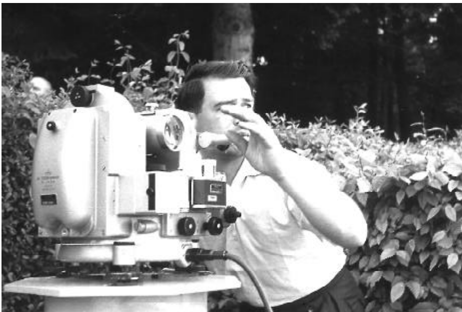
Abb. 2 Basisvergrößerungsmessung Meppen mit dem Gigos-Theodolit 1961
