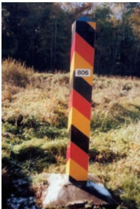
führung bereit. Zur gleichen Zeit begannen die Kräfte des Bundesgrenzschutzes mit der örtlichen Montage der Hülsen. Die Grenzmarkierungshülse wird dabei den alten Betonsäulen übergestülpt, seitlich angebohrt und mit Montageschaum lotrecht arretiert. Abschließend wird die gültige Nummer der Grenzmarkierungssäule aufgebracht.
